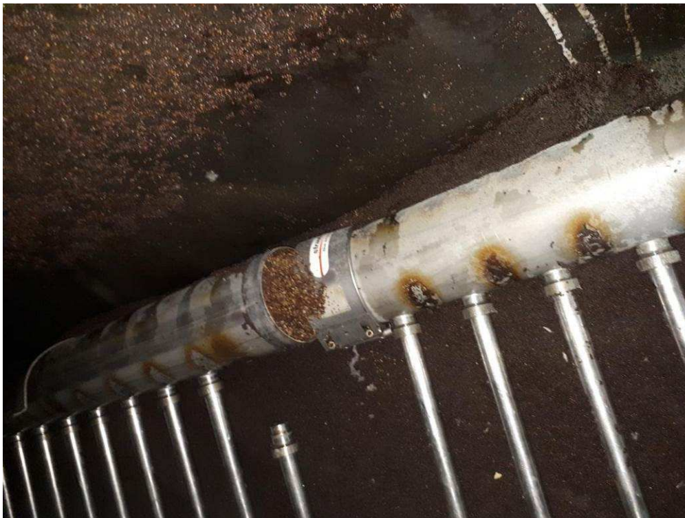
Rampe de la cellule 7 avant réparation
