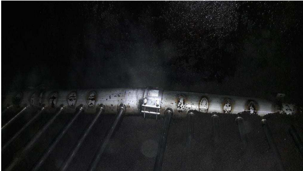
Rampe de la cellule 5 avant réparation
