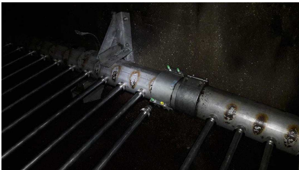
Rampe de la cellule 7 après réparation
